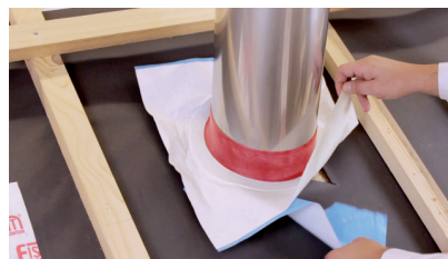
Schritt 2: Kürzere Schutzfolie von der Unterseite lösen.
