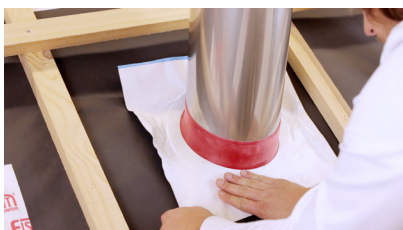
Schritt 3: Klebefolie ausrichten und auf die staubfreie und trockene Folie anreiben.
