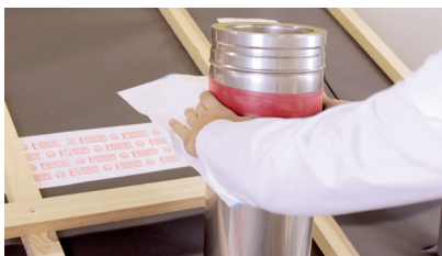
Schritt 1: Vorsichtig überschieben. Achtung bei Klemmbändern!
