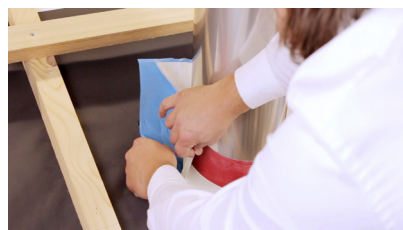
Schritt 4: Restliche Schutzfolie von der Unterseite entfernen.
