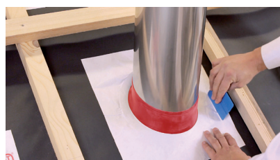
Schritt 6: Luftblasen mit Raker oder Handfläche nach Aussen
