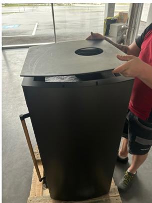
a) Wenn der Ofen angeschlossen ist, kann die Topplatte nach oben geschoben und, mit z. B. Holzklötzen, unterbaut werden. Achtung: Das Gewicht der Topplatte nicht auf der silbernen Folie und den darunterliegenden Rohren ablegen. Die Platte sollte an den Blechen vorne (oberhalb der Ofentüre) und hinten abgestützt werden. Es werden ca. 10 - 15 cm Arbeitshöhe benötigt. Hierzu eine zweite Person hinzuziehen.
